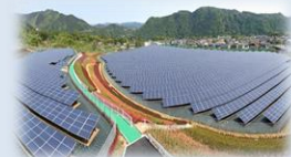
愛川太陽光発電所
